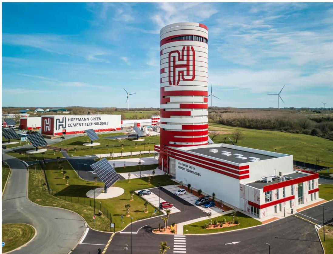
L'unité de production « H2 » de 70 mètres de haut, reposant sur un process « gravitaire » et entièrement construite en béton Hoffmann Green, a une capacité de production de 250.000 tonnes de ciment par an. Ce modèle d'unité est celui qui sera dupliqué pour les développements en France et à l'international de la Société.
