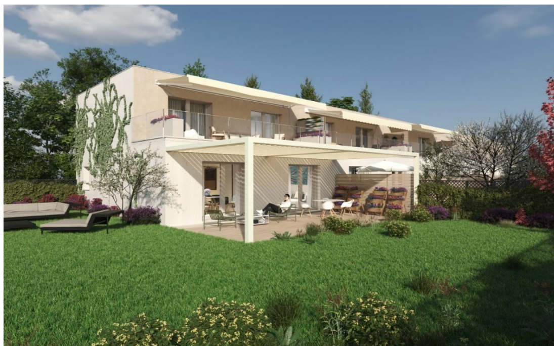
Chêne-Blanc, un ensemble immobilier de 6 villas construites à partir de béton à base de ciment décarboné Hoffmann Green
