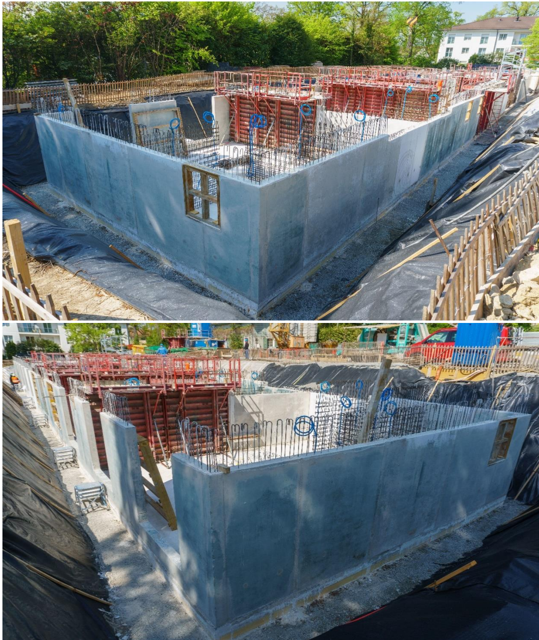
Lancement du chantier du Chêne-Blanc sur la commune d'Onex en Suisse
