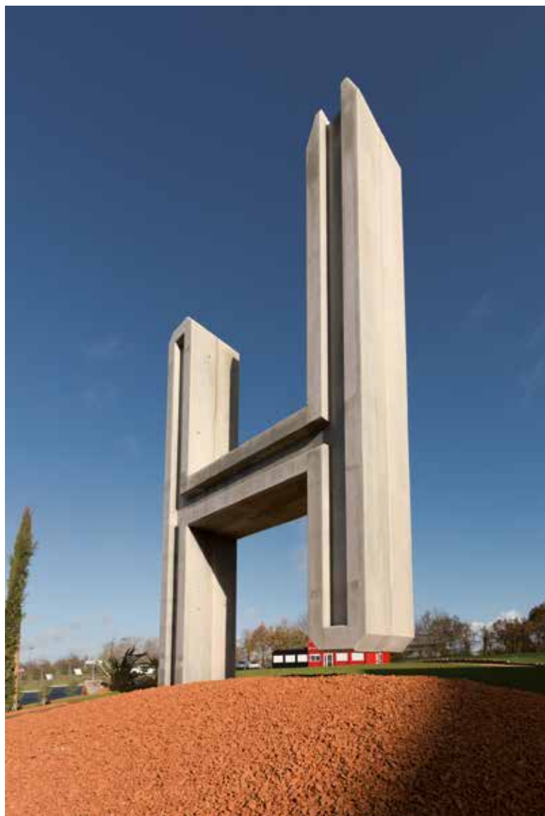
Le "H" de Hoffmann Green Cement Technologies a été préfabriqué en béton formulé avec le ciment sans clinker H-UKR. Il trône devant l'entrée de l'usine.
